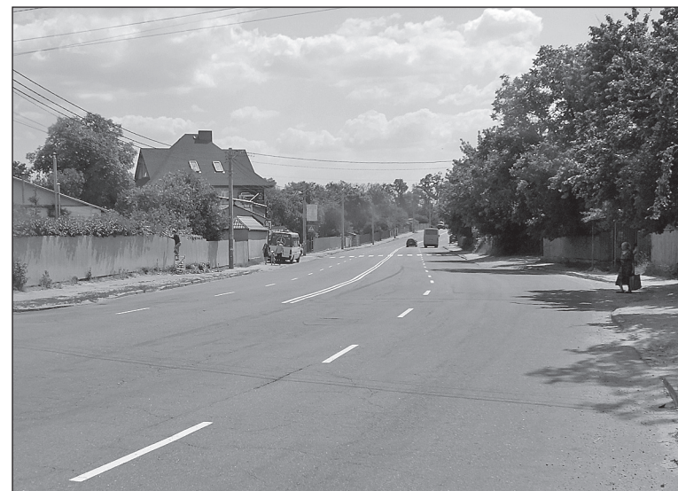
Нанесено розмітку на дорожнє полотно головних вулиць міста.
