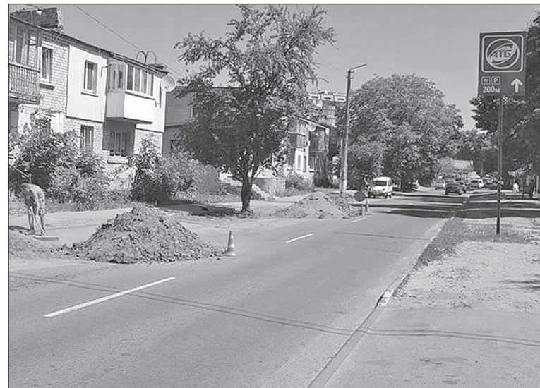
Триває очищення прибудовної території від піску та газонів від багаторічних нашарувань ґрунту.
