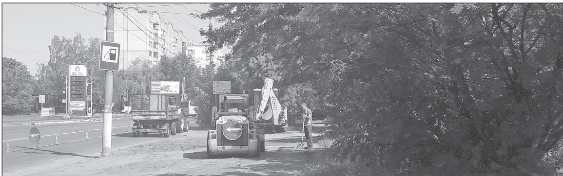
Проводиться благоустрій зеленої зони по вул. Білогородській
