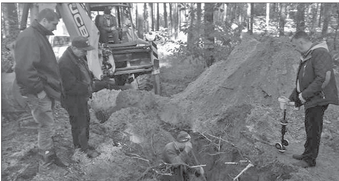
Фахівцями дільниці водопідйому з 01 до 05 жовтня 2018 року виконано аварійно-відновлювальні роботи на магістральному водопроводі (Д-150 мм) від артезіанських свердловин № 12, 13, 14, 15, 20 (с. Забір'я) до ВНС-2.
