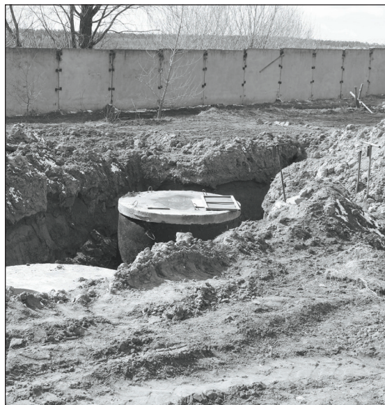
Вже побудовано розв'язки водопостачання, змонтовано каналізаційно-насосну станцію та підготовлено фундамент для встановлення модуля станції
