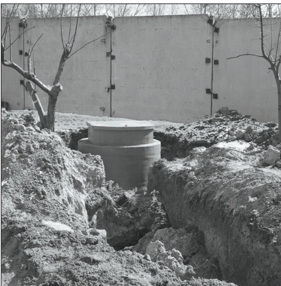
Вже побудовано розв'язки водопостачання, змонтовано каналізаційно-насосну станцію та підготовлено фундамент для встановлення модуля станції
