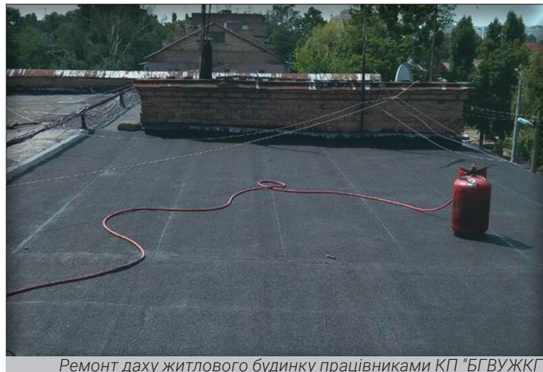
Ремонт даху житлового будинку працівниками КП «БГВУЖКГ»
