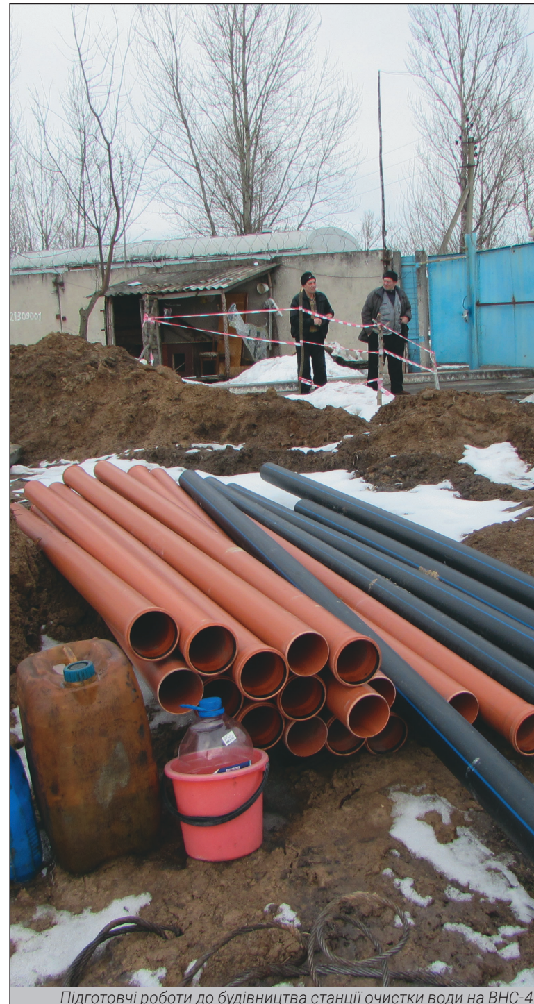
Підготовчі роботи до будівництва станції очистки води на ВНС-4
