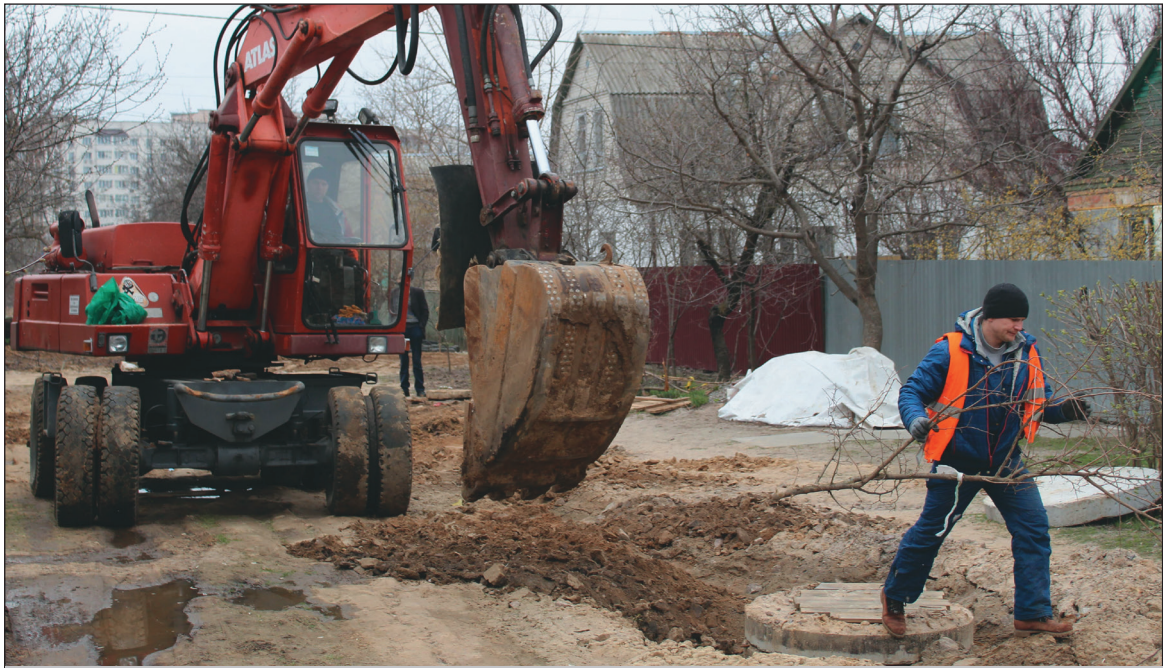
Заміна водогону по вул. Вербній
