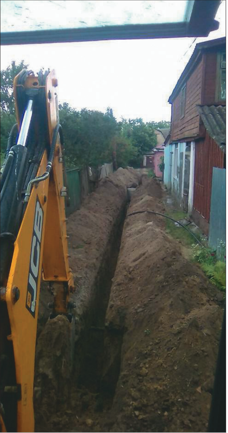
Заміна водогону між вул. Хрещатик та пров. Малий
