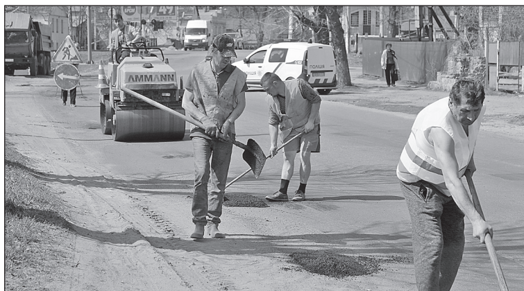
У Боярці розпочався ямковий ремонт доріг. КП «БГВУЖКГ» за допомогою підрядної організації ремонтує центральні вулиці міста. Почали зі старої частини міста — вулиці Шевченка.
